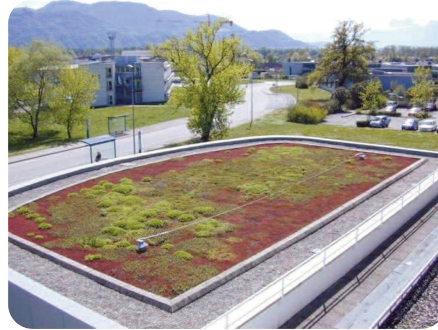
Toiture végétalisée sur une école d'ingénieur en Isère (38)
