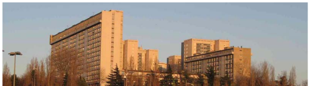
"Grande Terre des Vignes" - copropriété privée à Venissieux, qui a engagé des travaux de rénovation performante
