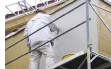
Panneaux de fibre de bois et enduit minéral
